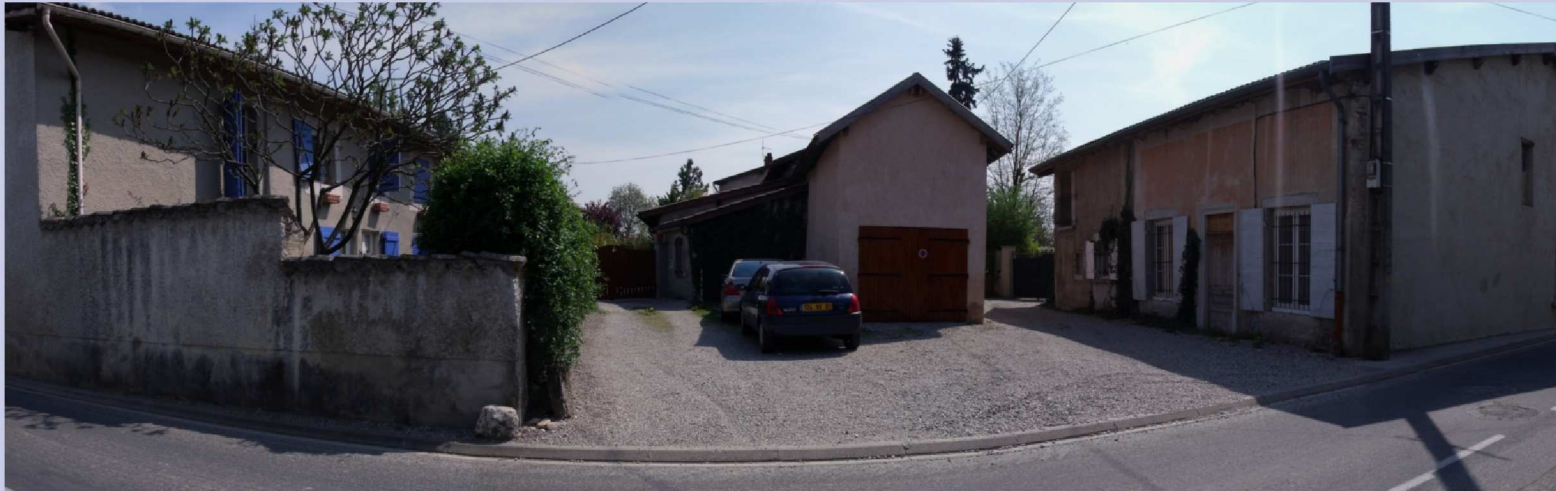
PHOTOGRAPHIE 28 : L'orientation du bâti par rapport à la rue offre des cours où espace public et privé se confondent.
