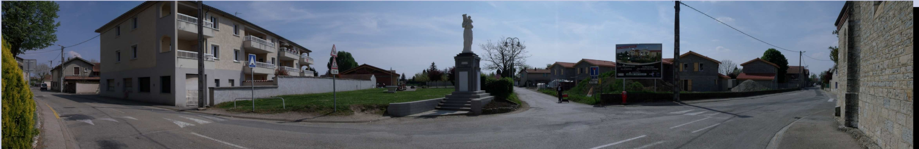
PHOTOGRAPHIE 33 : Face à l'Eglise, des typologies plus contemporaines viennent combler les dents creuses du centre villageois. Le mélange des gabarits et des typologies engendre un paysage "patchwork" sans identité affirmée.
