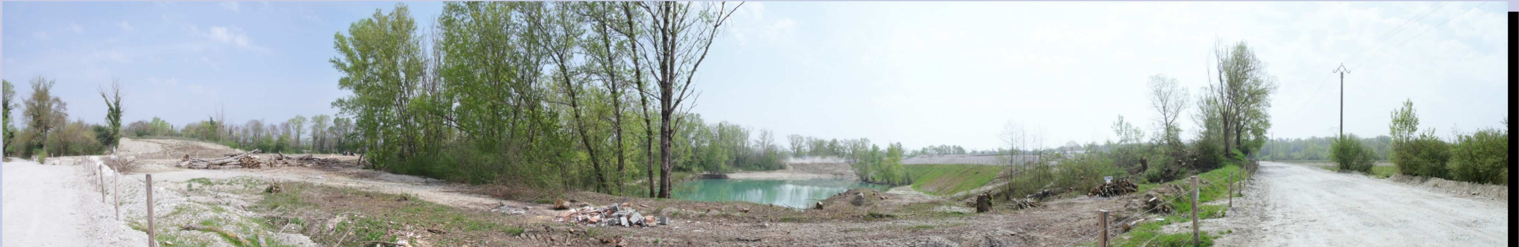
PHOTOGRAPHIE 03 : Vue du site carrier en exploitation à l'Isle Rosière : dans cette partie de l'unité se dessine un paysage tourmenté en perpétuelle transformation : la mutation accélérée du paysage recrée de nouvelles identités paysagères.
