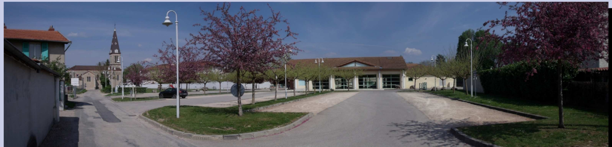
PHOTOGRAPHIE 25 : Vue de la salle polyvalente de Niévroz, dans la continuité des bâtiments de l'Ecole et de l'Eglise contemporaine de l'Assomption.
