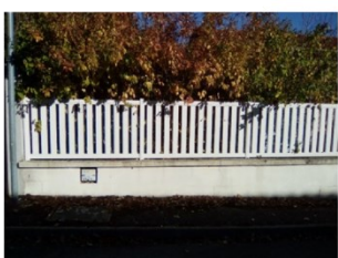
Mur bahut accompagné d'un dispositif à claire voie et doublé d'une haie
