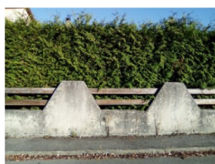
Mur bahut accompagné d'un garde corps et doublé d'une haie
