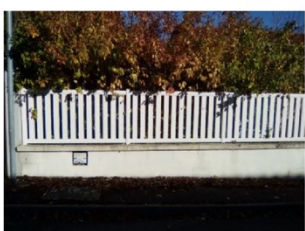
Mur bahut accompagné d'un dispositif à claire voie et doublé d'une haie
