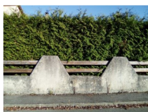
Mur bahut accompagné d'un garde corps et doublé d'une haie
