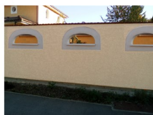
Mur à ouvertures
