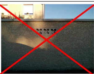
Mur plein avec ouvertures bouchées
