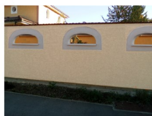
Mur à ouvertures
