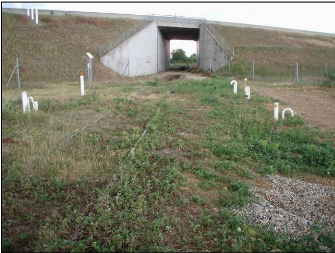
Ouvrage de passage du CFEL sous l'A432.
