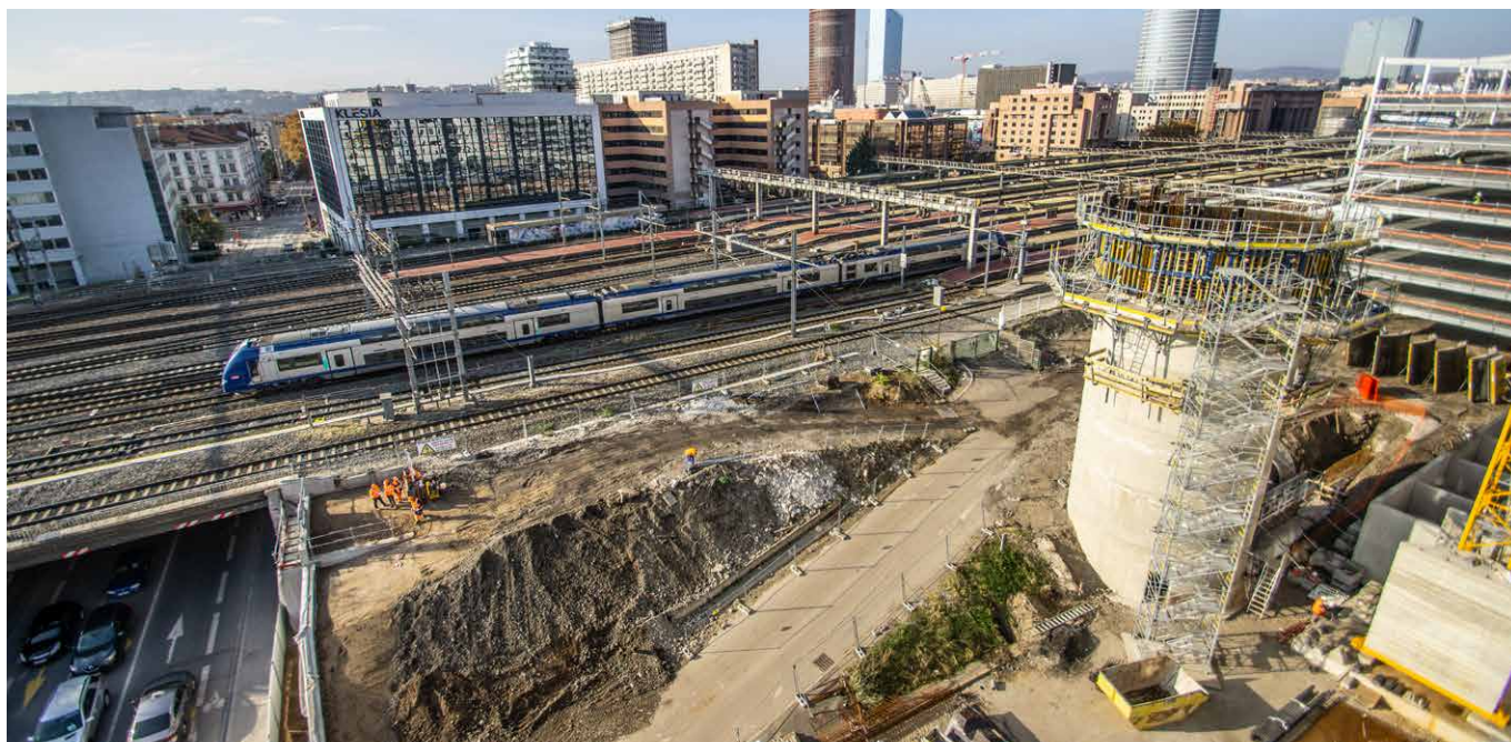
Les travaux du Plan de mobilisation en gare de Lyon Part-Dieu, 2019
