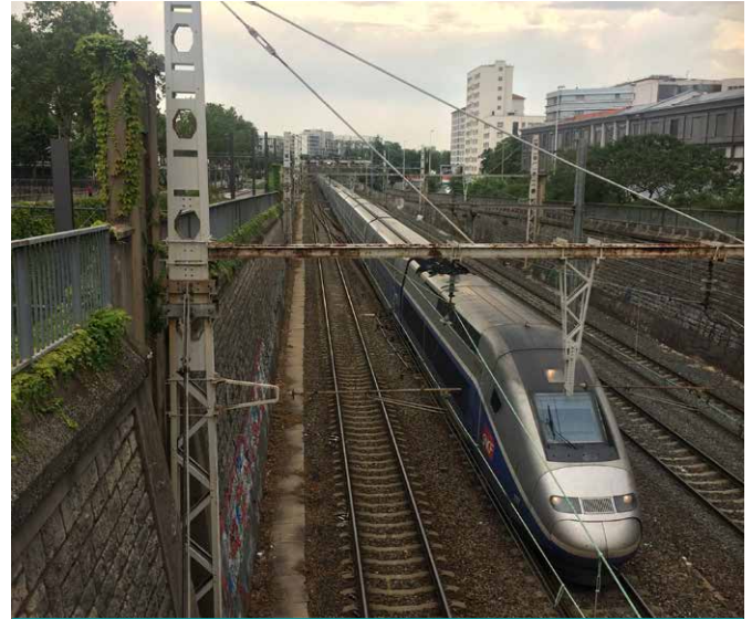
La tranchée de la Guillotière, au cœur du nœud ferroviaire
