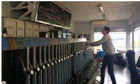
ANCIEN POSTE MÉCANIQUE À LEVIERS. Plus de 30 postes de ce type encore en service en 2018 dont certains sur la région Auvergne – Rhône-Alpes à Ambrérieu et Bourg-en-Bresse par exemple) - Source : SNCF Réseau
