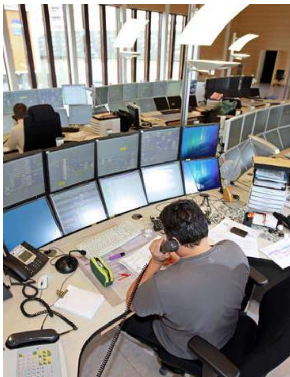
SALLE DE LA COMMANDE CENTRALISÉE DU RÉSEAU Source : SNCF Réseau
