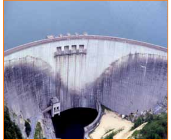
barrage de Vouglans
