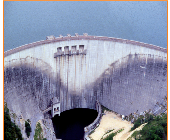
barrage de Vouglans
