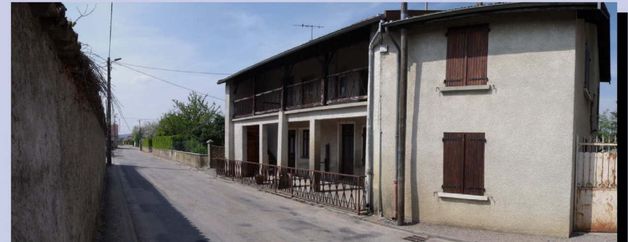
PHOTOGRAPHIE 31 : Le bâti traditionnel présente sa façade principale ou son pignon à front de rue.
