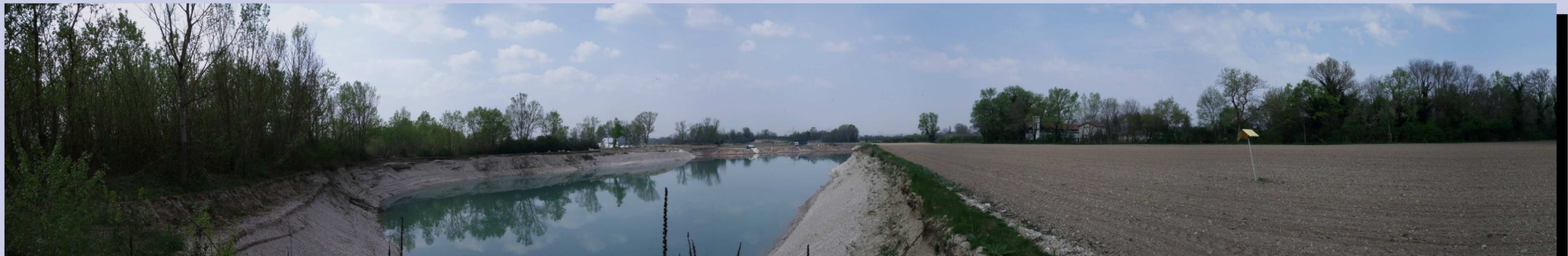
PHOTOGRAPHIE 04 : Vue du lac en formation après l'exploitation à l'extrémité Est du même site carrier. Quelque soit sa reconversion, il ne faut pas oublier la perte significative de surface agricole qu'il induit, déjà importante sur le territoire.
